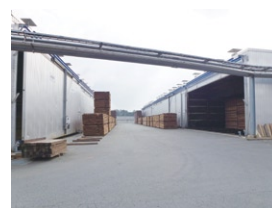
写真3 1基150mの乾燥機
