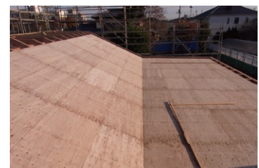
写真8 構造用合板による折板
