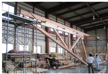
写真17 二重合成梁モックアップ
