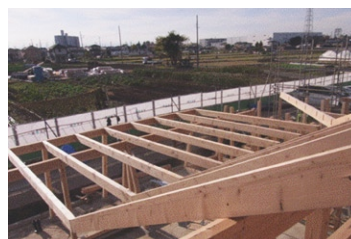
写真7 吊梁のセット
