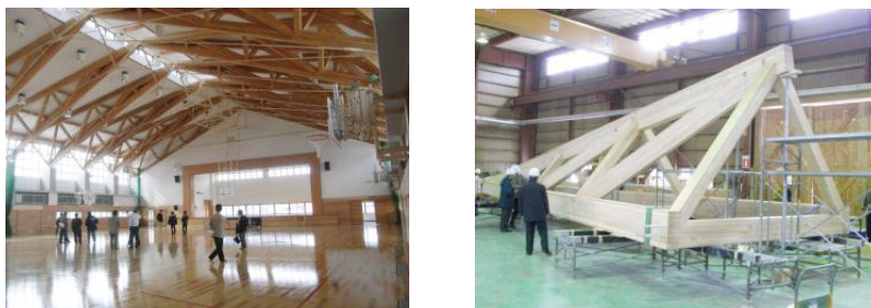
図3 秋田県二ツ井小学校体育館(左)と架構検討の様子(右)
