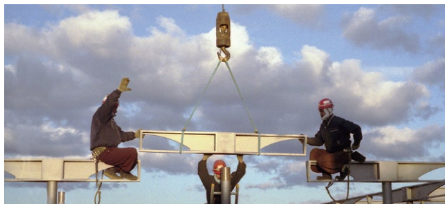
写真26 柱と梁ユニットの接合
