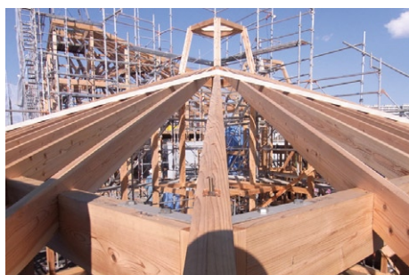
写真3 ダイアゴナルアーチ
