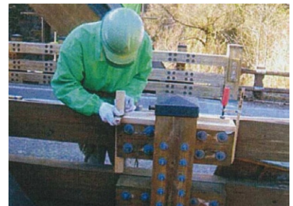
写真1 木橋高欄部の補修 *1 腐った部分をのみ等で除去し、心材に接着剤を塗布して端金で心材を固定し補修している。
