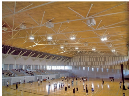
写真：山佐木材が設計者サポート、施工した事例（上／芦北町地域資源活用総合交流促進施設、下／始良総合運動公園体育館）
