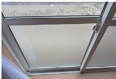
写真5：アルミと樹脂の複合サッシと複層ガラスで断熱性能を確保した開口部
