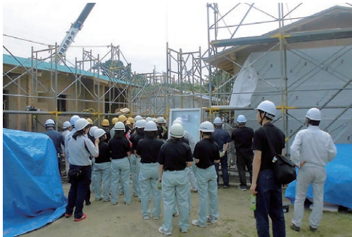
写真7：5月27日、熊本県立小川工業高等学校建築科の生徒が建設現場を見学
