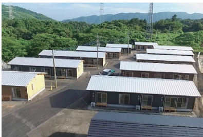
写真1: 玄関袖壁に熊本県スギの間柱を使用
