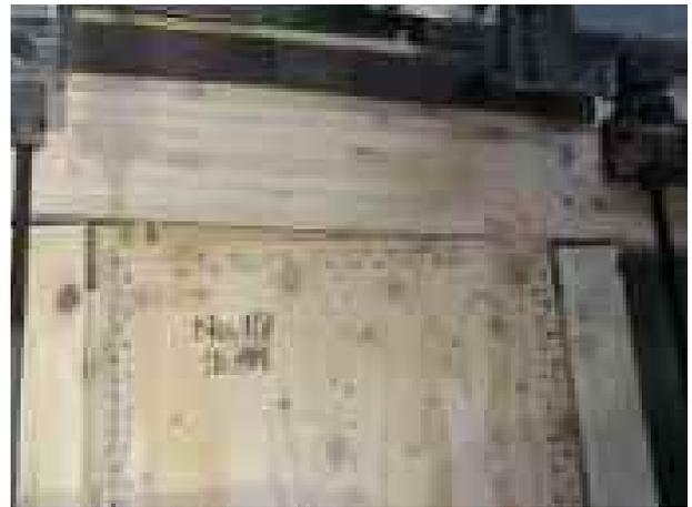
柱頭側：面材の桁へのめり込み
