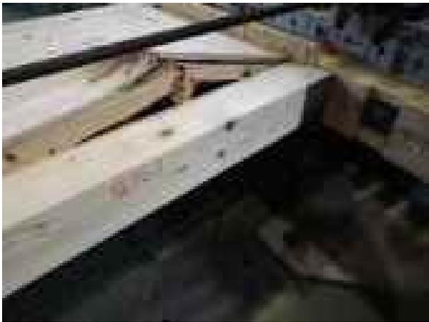
柱脚側:受け材の圧壊に伴う面材破壊
