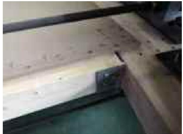
柱頭側：釘の破断、パンチングアウト等
