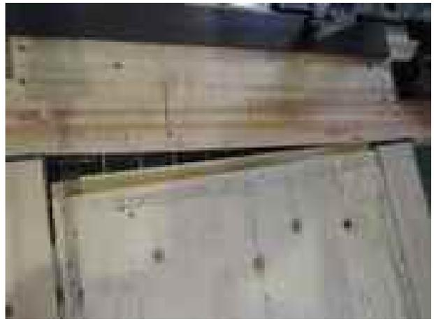
柱頭側:桁側受け材ビスの抜け
