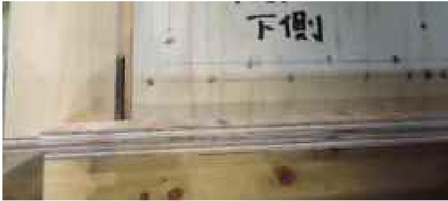
写真 2.2-1 壁面材と床面材の納まり（隙間なし）
