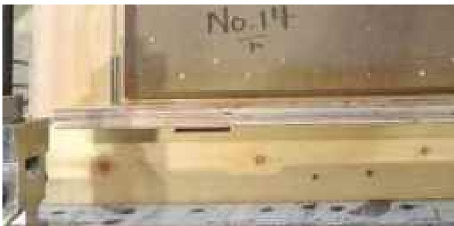
写真 2.2-2 壁面材と床面材の納まり（隙間 12mm）
