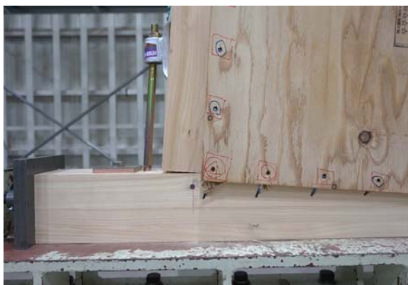
面材の縁切れ、くぎの引抜け
