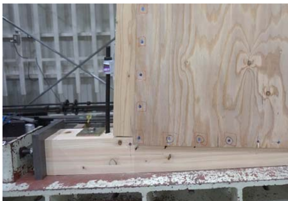
くぎの引抜け
