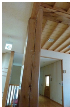
写真7 柱の割れ
