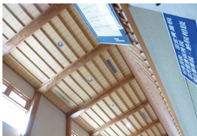
写真4 ホール吹き抜け上部のマツの大梁
