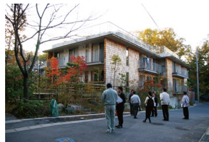
写真17 ウッドシングルによる外壁
