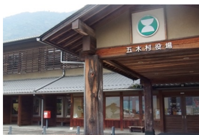
写真8 ポーチ独立屋根の柱
