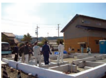
現場施工研修(基礎断熱工事の完了現場)
