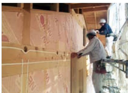
現場施工研修(断熱工事の施工手順)
