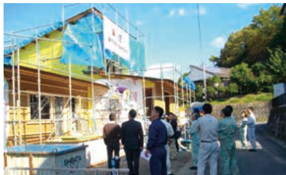
省エネ住宅の現場研修
