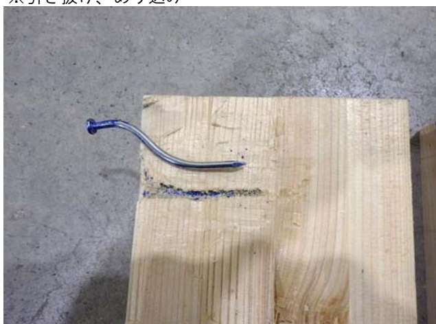
写真-88 「19-S_P18-75_II(単) 解体後」
