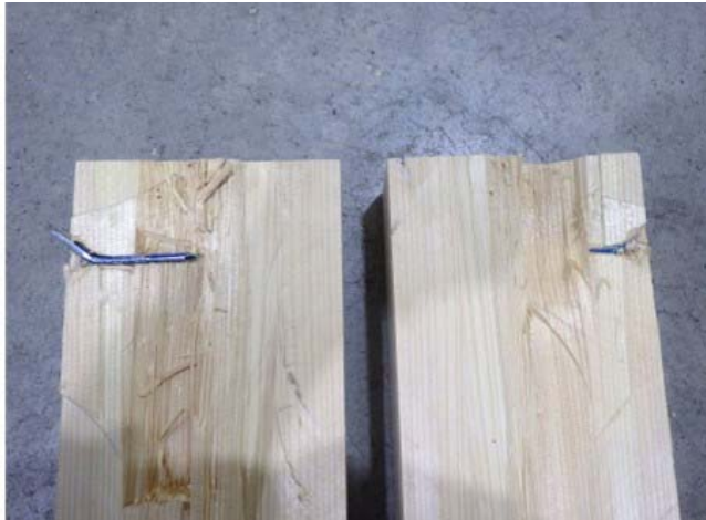
写真-61 「12-S_Wk18-75_II(緑) 解体後」
