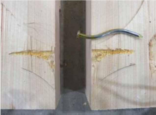
写真-37 「8-S_Wh18-65 解体後」
