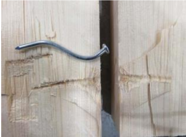
写真-153 「29-S_P18-7583 解体後」
