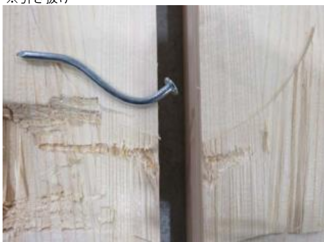
写真-161 「31-S_P18-7591 解体後」
