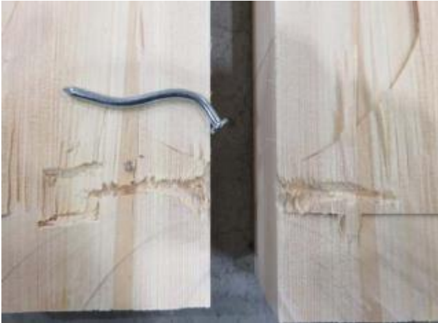
写真-157 「30-S_P18-(75)65 解体後」
