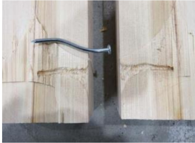
写真-85 「17-S_Ws24-7591 解体後」
