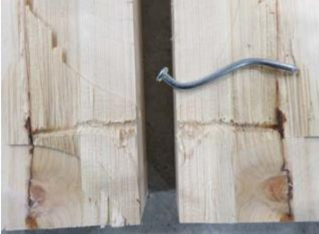
写真-17 「4-S_Wk18-7583 解体後」
