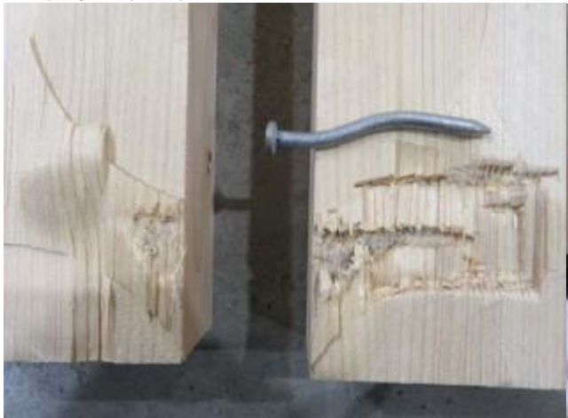
写真-61 「14-S_Wh18-80 解体後」
