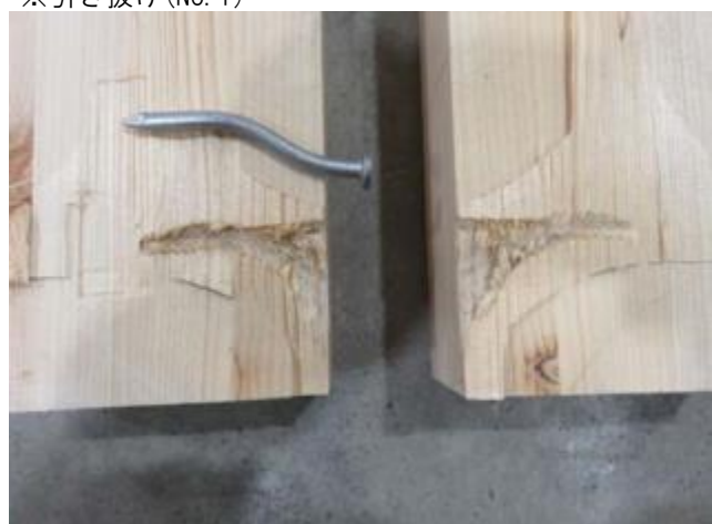
写真-29 「7-S_Wk18-80 解体後」
