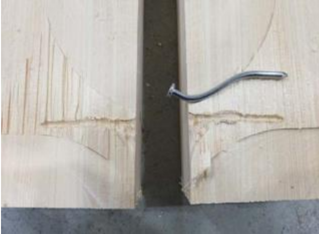
写真-57 「13-S_Wh18-7591 解体後」
