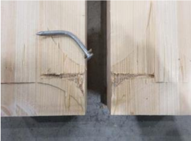
写真-165 「32-S_P18-80 解体後」
