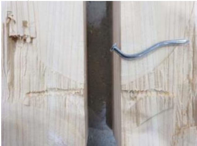
写真-13 「3-S_Wk18-6581 解体後」
