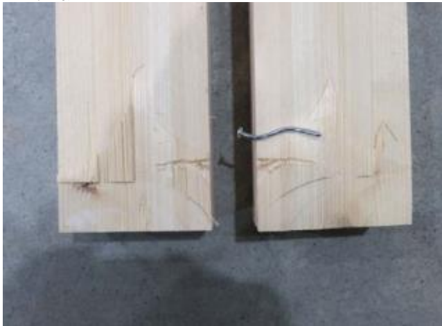
写真-45 「10-S_Wh18-6581 解体後」
