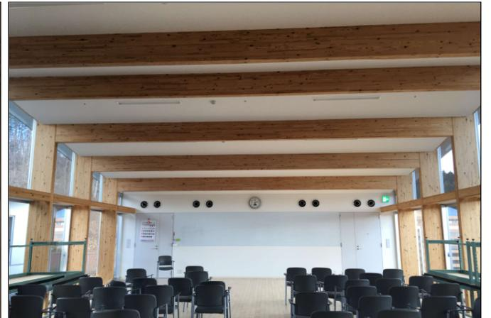
大断面集成材を用いた門型フレームによる大空間
