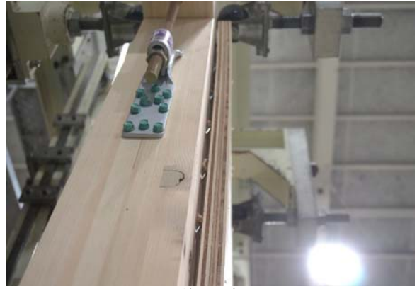
くぎの引抜け
