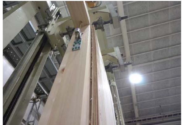
くぎの引抜け
