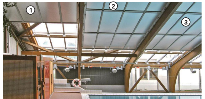
写真3 太陽の郷プールガーデンの湿度管理策 太陽の郷プールガーデンでは、室内水蒸気を積極的に結露させ、結露水を屋外に排除するいわゆる除湿の手法を用いている 39) 。可動式断熱戸①②③を最下部まで下げ天窓を塞ぐ。すると外気に冷やされた天窓が結露発生板となり、天窓と断熱材の間に水蒸気が補給され、結露が続く 39) 。結露水は結露受け(図1)を経て戸外に自然排出される 39) 。これにより気化潜熱を失うことなく、翌朝の湿度を40～50%に維持できる 39) 。
