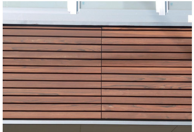
写真4 グランダ多摩川・大田 (有料老人ホーム) 外壁に防火処理木材を使用している。施工後の着脱を容易にし、メンテナンス性を向上させている。
