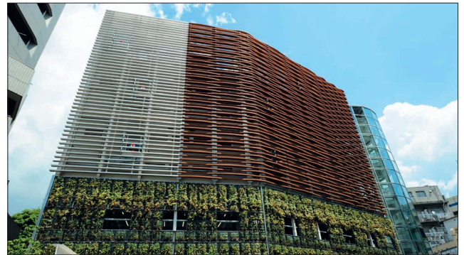
写真2 東京都港区立麻布図書館 - 外装に使用された熱処理木材
