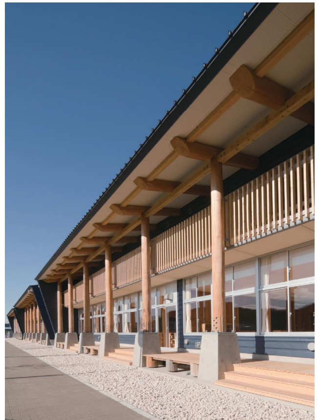
茂木町立茂木中学校（栃木県） 維持管理コストがかかる樋をつける代わりに、軒の出を深くし雨水の落下範囲を玉石敷きにして雨水の跳ね返し高さを抑えた設計とした。
