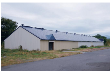
1958年築の集成材建築物(北海道砂川市):築50-51年時の写真である。材はエゾマツ、接着剤はユリア樹脂による集成材を使用している 1) 。撮影:新藤健太
