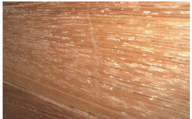
写真6 白華による塗膜の劣化
