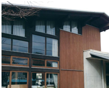
写真3 軒やけらばの出による保護効果の例(つくば市立東小学校)
