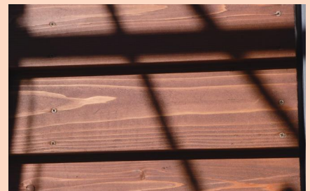
写真5 鹿沼市栗野第一小学校の下見板 一般的には召し合わせ部分でビスにて留め付けるのであるが、メンテナンスの容易性に配慮しビスが隠れないように施工した。
