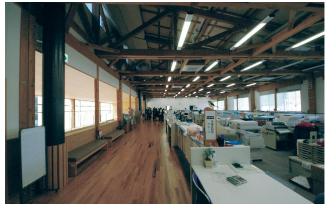
写真3 天竜区役所2階役務室 左の明るい部分は1階につながる吹き抜けの天井面で、小屋裏には2階の天井点検口からアプローチできる。右は2階の役務室で、小屋組を現しにしており、脚立等によって容易に小屋組にアプローチできる。
