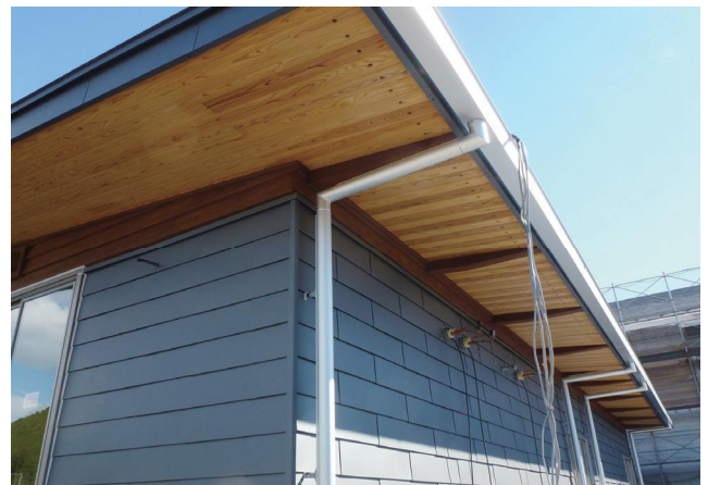
写真2 鹿沼市立栗野第一小学校(2014年竣工) 2階床ラインまでガルバリウム鋼板を張り上げ、それより上部をスギ下見板張りとしている。
