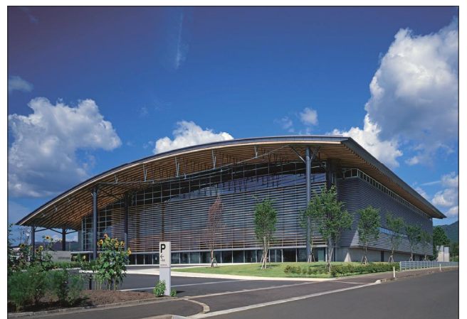
写真2 大館市樹海体育館 メインアリーナの他サブアリーナ、会議室・研修室などが大屋根内に収まっている。
