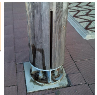
写真1 雨掛かりにある玄関エントランスの独立柱金物がプレート状で横方向に遮るものがない形状であるため、万が一継ぎをすることになった場合でも柱を抜くのが容易である。
