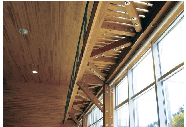
天竜区役所（静岡県浜松市） 吹き抜けのガラスのカーテンウォールの中にキャットウォークを設置し構造用金物の増し締めを行うためのアプローチを容易にした。
