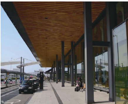
写真2 軒裏に使用された木材(阿蘇くまもと空港) 軒裏は日当たりや雨掛りが少ないため、比較的透明性の高い塗装でも劣化が緩やか。
