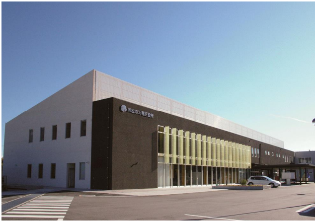
天竜区役所（静岡県浜松市） （木造で内装木質化）：メンテナンス費用の低減を優先し、外部に木材を使用しない設計とした。
