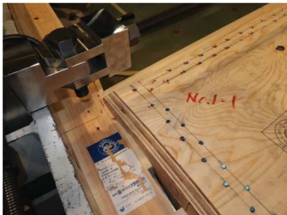
反加力側の柱脚部
