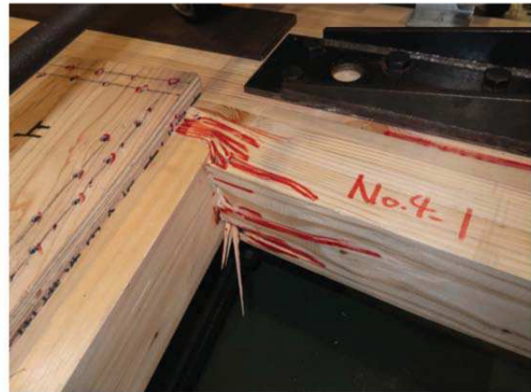
加力側の柱頭部(めりこみ破壊)
