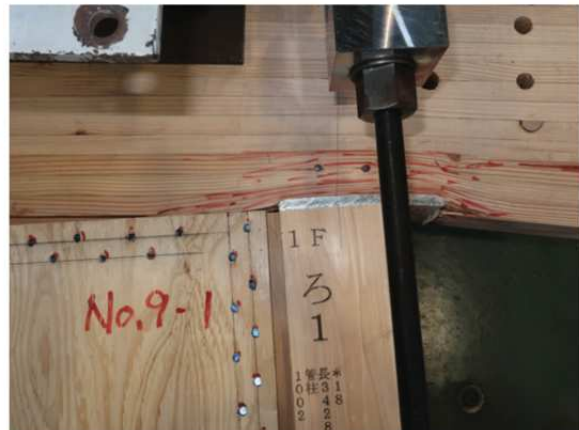
加力側の柱頭部(めりこみ破壊)
