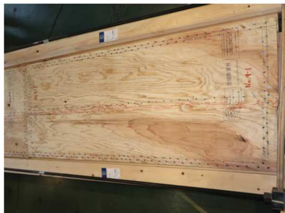
下側の面材(面材のせん断破壊)
