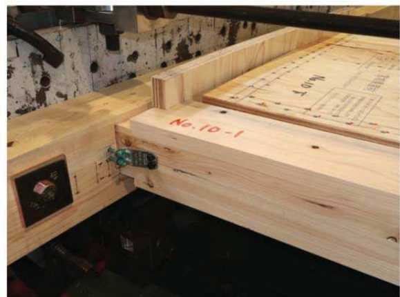
加力側の柱脚部(柱の引き抜け)
