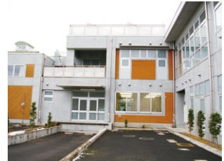
写真36 左側の外壁は軒の出があり塗料の落ち無し(卓越風の風下に当たる)
