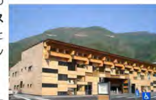
RC 造と木造の混構造による庁舎の例：高知県梺原町総合庁舎（2009 年竣工） （出典：（財）建築環境省エネルギー機構 HP）
