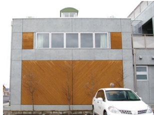
写真34 外壁木部の塗料落ち有り
