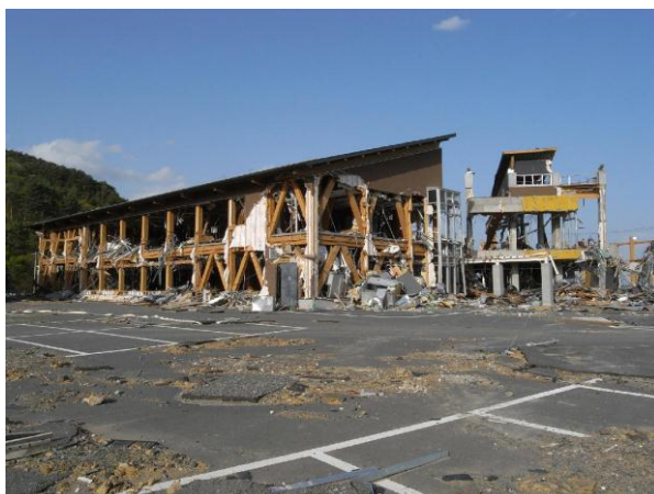
写真5 残った集成材建物（石巻市）
