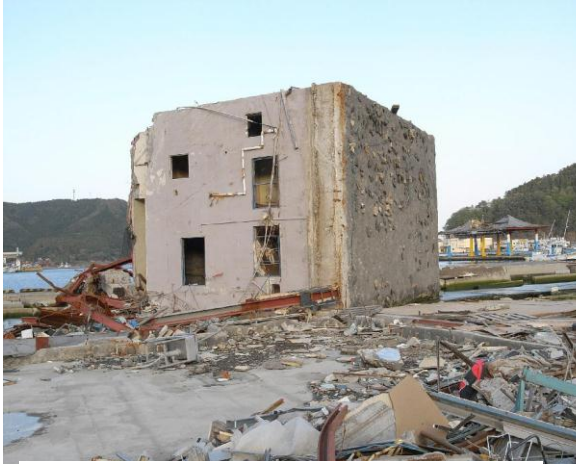
写真1 横倒しになったRC造建物
