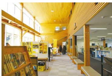
写真8 天竜区役所 吹き抜け空間に小屋組を見せずボルトの増し締めの必要が無いデザインとした。
