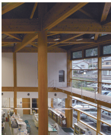
写真3 春野協働センター 吹き抜けのガラスのカーテンウォールの中に設けられたキャットウォーク。
