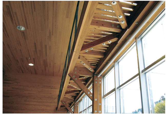
天竜区役所（静岡県浜松市） v 吹き抜けのガラスのカーテンウォールの中にキャットウォークを設置し構造用金物の増し締めを行うためのアプローチを容易にした。
