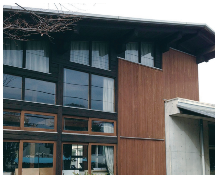
写真2 軒裏に使用された木材(阿蘇くまもと空港) 軒裏は日当たりと雨掛りが少ないため、比較的透明性の高い塗装でも劣化が緩やか。
