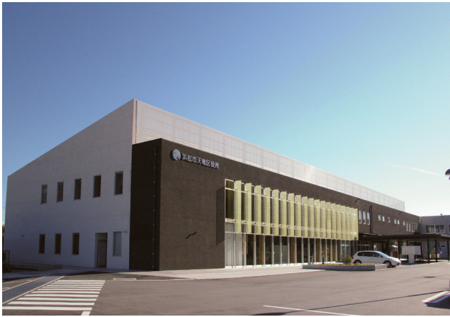
天竜区役所（静岡県浜松市） （木造で内装木質化）：メンテナンス費用の低減を優先し、外部に木材を使用しない設計とした。
