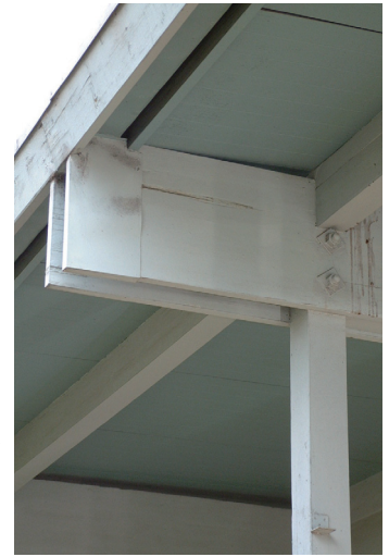
写真3 合わせ梁先端部の金属被覆
