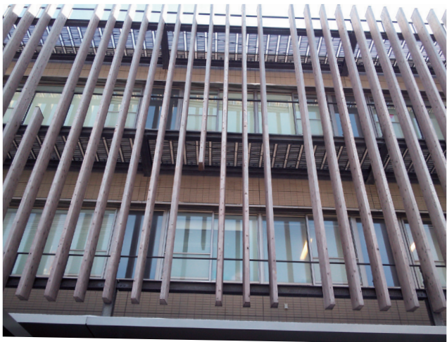
岡市総合保健福祉センター（山形県） （RC造で内・外装木質化）：外壁面の木質系ルーバーの塗り替えに配慮し、キャットウォークを設置した。
