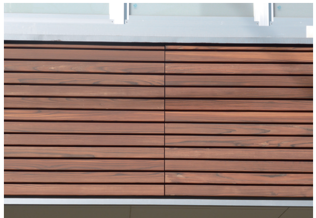
写真4 グランダ多摩川・大田 (有料老人ホーム) 外壁に防火処理木材を使用している。施工後の着脱を容易にし、メンテナンス性を向上させている。
