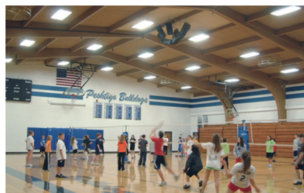
Unit Structures(現Sentinel Structures)社のU.S.A(WI)の集成材建築物群:紫外線の届かない屋内部分であるため劣化が無い。左はPeshtigo Middle-High School 図書館(旧体育館)で築74年の時の写真である。材はサザンイエローパイン、接着剤はカゼイン接着剤による集成材を使用している。右は同体育館で築51年の時の写真である。材はサザンイエローパイン、接着剤はフェノール・レゾルシノール接着剤による集成材を使用している 1)~3) 。
