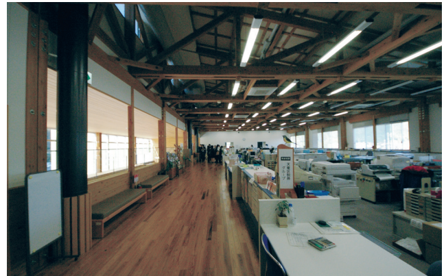
写真2 天竜区役所2階作業室 左の明るい部分は1階につながっている吹き抜けの天井面で、小屋裏には2階の天井点検口からアプローチできる。右は2階の作業室で、小屋組を現しにしており、脚立等によって容易に小屋組にアプローチできる。
