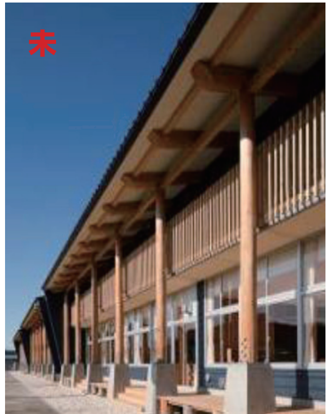
茂木町立茂木中学校（栃木県） 維持管理コストがかかる樋をつける代わりに、軒の出を深くし雨水の落下範囲を玉石敷きにして雨水の跳ね返し高さを抑えた設計とした。
