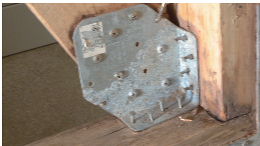
写真1 劣化環境下におかれたパネルの耐力壁強度試験 14)
