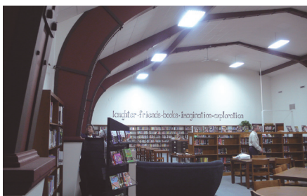
Unit Structures(現Sentinel Structures)社のU.S.A(WI)の集成材建築物群:紫外線の届かない屋内部分であるため劣化が無い。左はPeshtigo Middle-High School 図書館(旧体育館)で築74年の時の写真である。材はサザンイエローパイン、接着剤はカゼイン接着剤による集成材を使用している。右は同体育館で築51年の時の写真である。材はサザンイエローパイン、接着剤はフェノール・レゾルシノール接着剤による集成材を使用している 1)~3) 。
