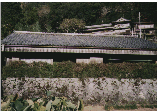
写真1 台風などの強風に備えて高く積み上げられた石垣(和歌山県) 地元で手に入れやすい石材を地域に伝承される石積みの技術で積み上げ、台風時などの強風ならびに強風をとまなう雨に対する備えとして見られる。
