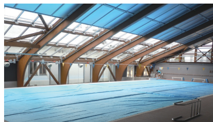
写真2 太陽の郷プールガーデンの湿度管理 秋口から春までの外気温の低い時期、プール表面をシートで覆って水の蒸発を防ぎ、プール棟空間への新たな水蒸気供給を絶つ 39) 。1983年竣工当時より行っている。
