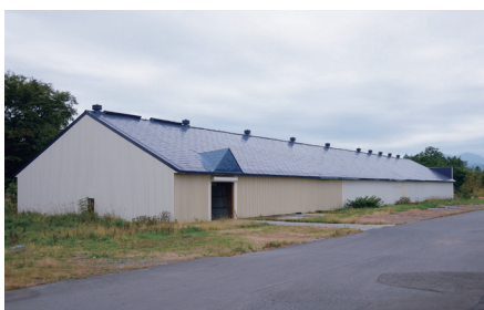
1958年築の集成材建築物(北海道砂川市):生物劣化が無く、築50年以上経過中。左は外観、右は内観である 1) 。
