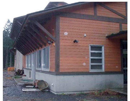
写真4 軒やけらばの出による保護効果の例(栃木県21世紀林業創造の森訓練棟) さらに基礎が高い場合には雨水の跳ねも少なく保護効果がより高まる。
