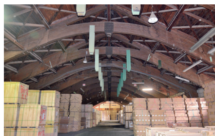
1958年築の集成材建築物(北海道砂川市):生物劣化が無く、築50年以上経過中。左は外観、右は内観である 1) 。
