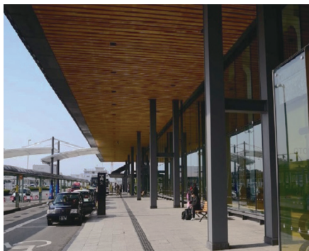
写真2 軒裏に使用された木材(阿蘇くまもと空港) 軒裏は日当たりと雨掛りが少ないため、比較的透明性の高い塗装でも劣化が緩やか。
