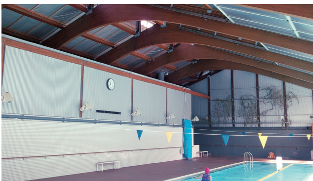
写真1 太陽の郷プールガーデン(1983年竣工、2006年移築) 換気・除湿は南側開口部と屋根頂部開口部とにより自然換気がされ、補助的に機械換気が併用される。
